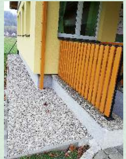
Fertigstellung Trockenlegung Keller
